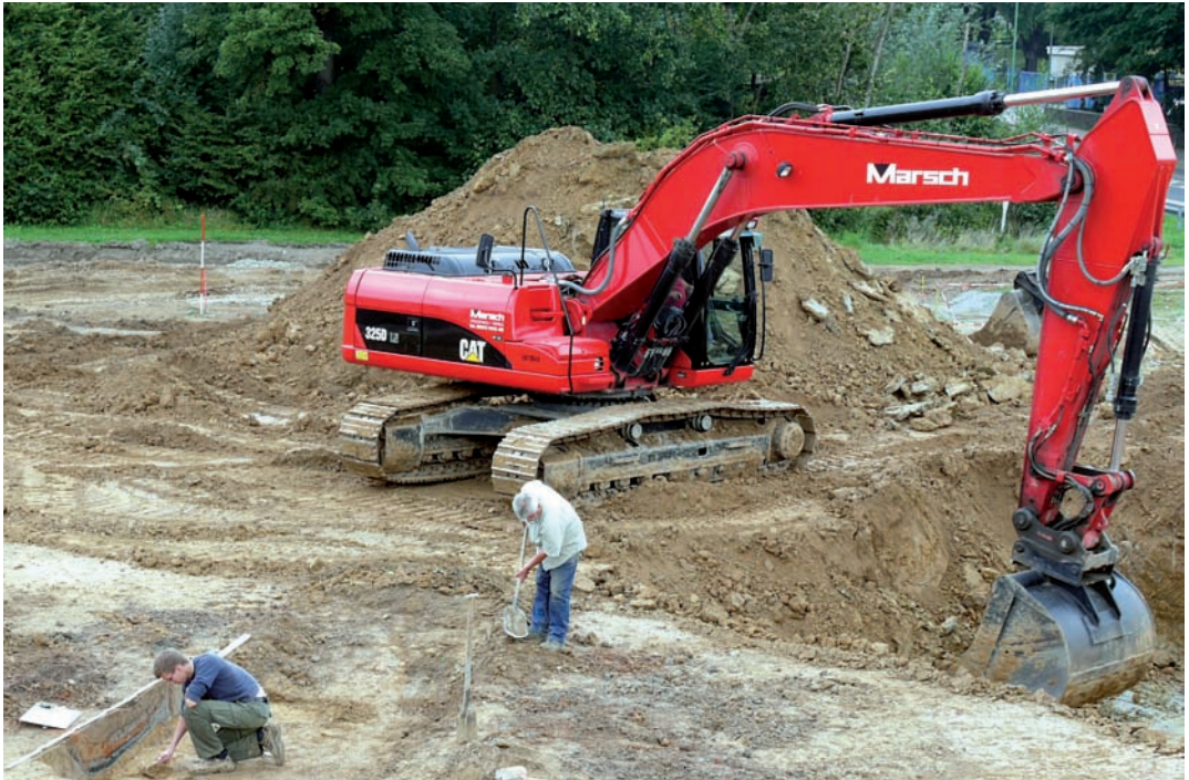
Notbergung von archäologischen Befunden bei Bauarbeiten in Hagen-Herbeck, 27.8.2008 (Foto: Eva Cichy).
